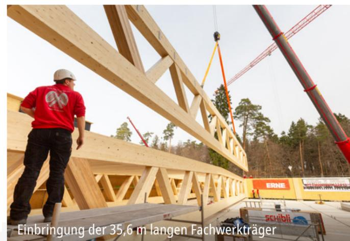
Einbringung der 35,6 m langen Fachwerkträger
