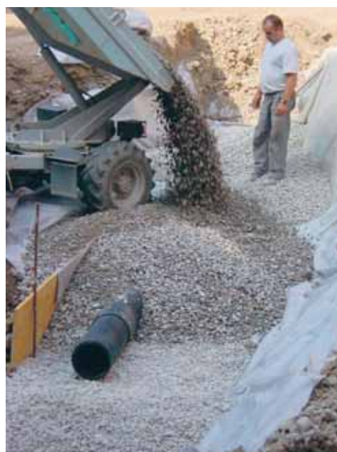
Unten: Bau einer Versickerungsanlage für die Rückgabe von abgekühltem Grundwasser
