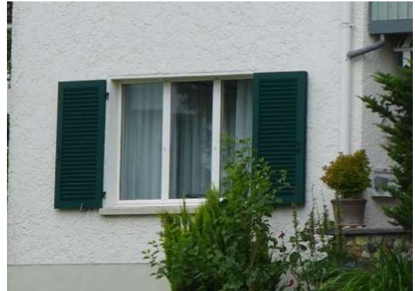
Abbildung 35: Ursprüngliches, dreiflügliges Fenster mit schmaler Mittelpartie, ohne Setzholz
