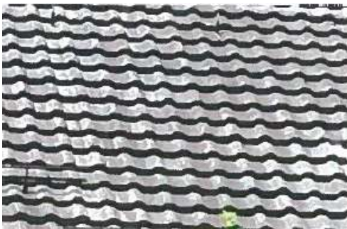
Abbildung 39: Beispiel ursprüngliche Ziegeleindeckung
