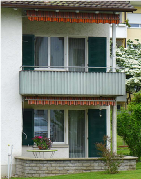
Abbildung 37: Bestehendes Beispiel für Klappläden
