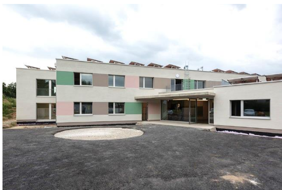
Ansicht Zugangsbereich aussen
