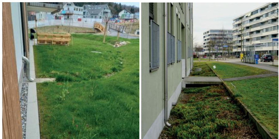
Abbildung 35 Beispiele dezentraler Retention
