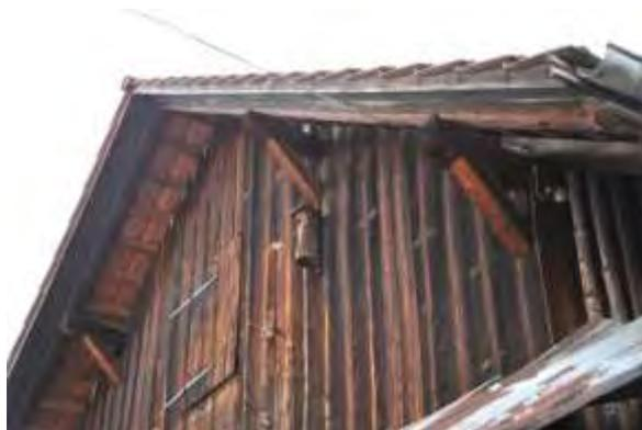
Abb. 83: Verschalte südliche Giebelfassade im Giebelfeld.
