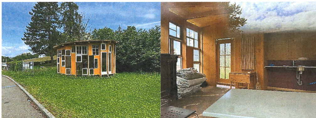
Abbildungen: Fertiggestellter Pavillon und Blick in den Innenraum.
