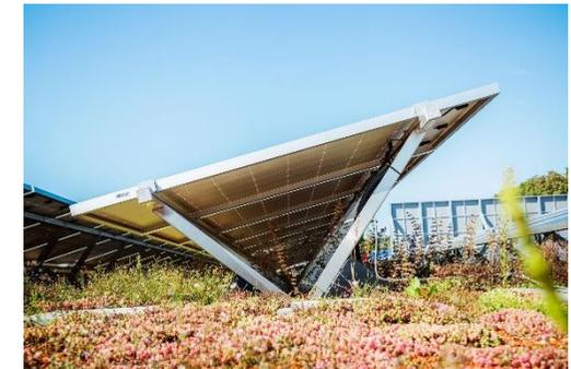
Begrüntes Dach mit 40 bis 80 cm Aufbauhöhe (tiefste vs. höchste Stelle), System „Contec greenlight“
