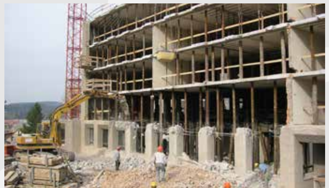
Abriss der Fassade des Hauses A im Zuge des Umbaus und der Erweiterung des Pflegezentrums, ca. 2002.
