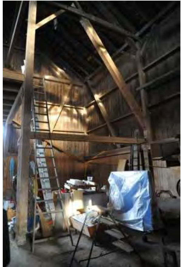
Abb. 73: Ökonomie mit geschossübergreifendem Ständer. Blick nach Norden.
