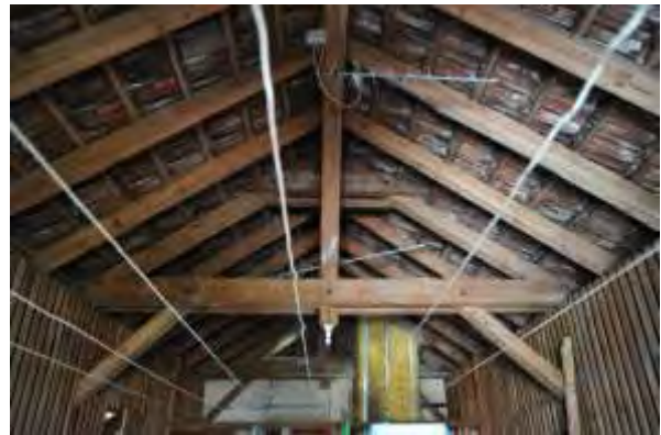
Abb. 71: Dachgeschoss, Dachwerk mit Hängesäule im 2. DG die von einer Kehlbalkenzange umschlossen wird (Q2 sowie im Hintergrund Q3).
