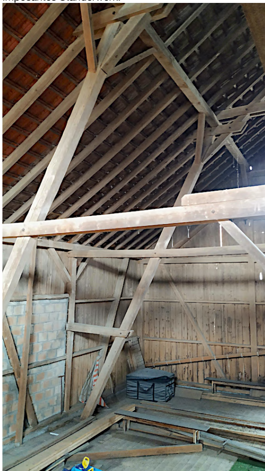
Blick auf die mittels Zangen ausgebildeten Sprengwerke in den Binderebenen.
