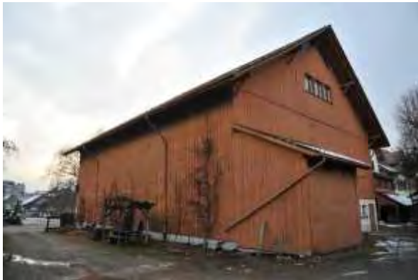
Abb. 25: Östliche Trauffassade des Ökonomiegebäudes mit Bretterschalung.
