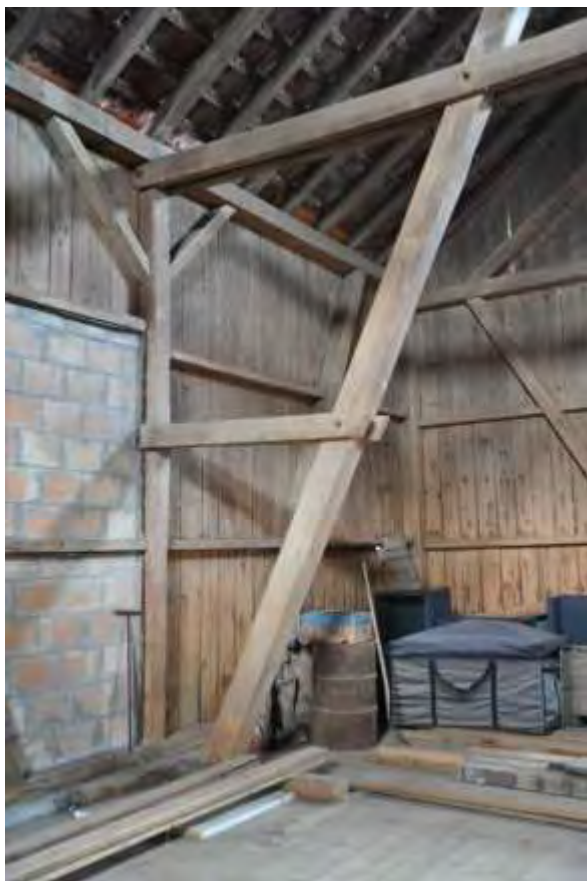
Abb. 76: Ökonomie, die Stuhlstrebe wird mit Zangen über die Traufwand ausgesteift (Q2). Blick nach Nordwesten.
