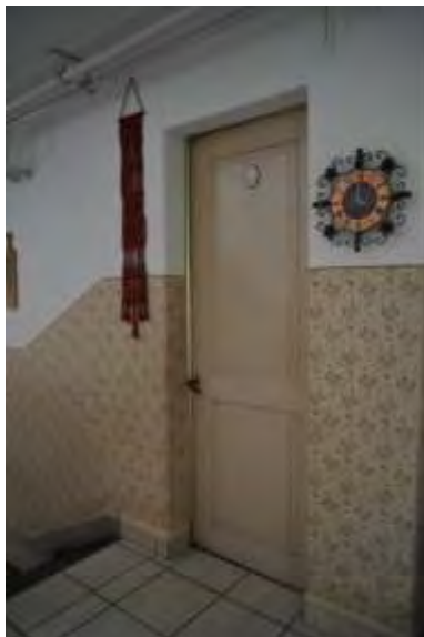
Abb. 39: Treppenhaus 001, zweifeldrige Rahmentür mit abgeplatteten Füllungen zum WC.
