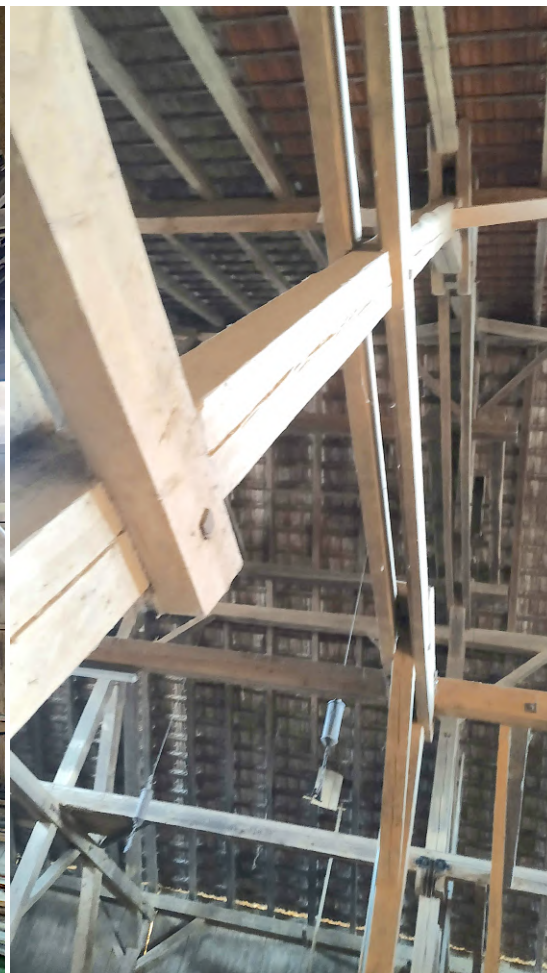
Blick auf die mittels Zangen ausgebildeten Sprengwerke in den Binderebenen.
