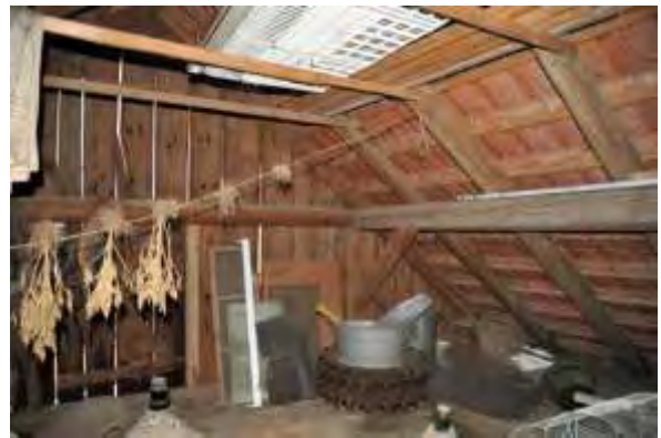
Abb. 104: Dachwerk mit südlicher Giebelwand, Blick nach Südwesten.
