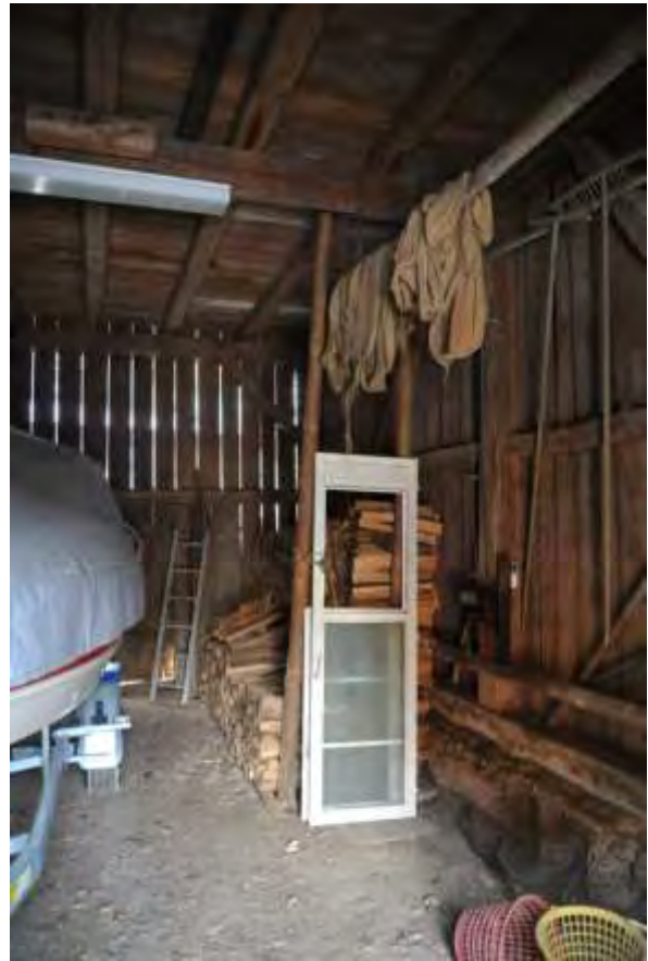
Abb. 100: Nördliche Querzone, Blick nach Nordwesten.
