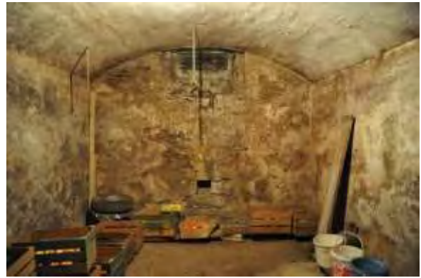
Abb. 91: Gewölbter Keller von 1882 nach Nordwesten.
