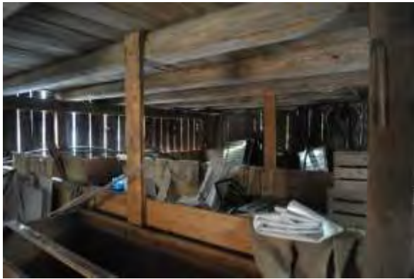
Abb. 101: Dachbalkenlage, Blick nach Südwesten.
