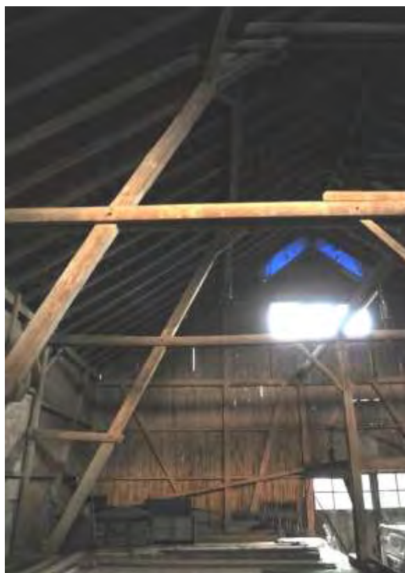
Abb. 79: Ökonomie, Blick in das Dachwerk nach Süden.
