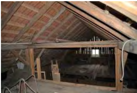
Abb. 103: Dachwerk mit Kehlbalke, Blick nach Norden.
