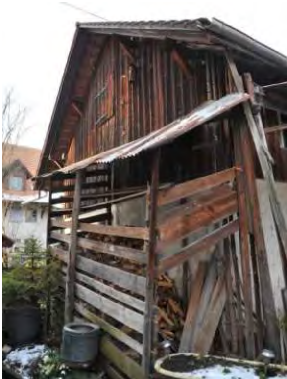
Abb. 84: Südliche Giebelfassade mit gemauertem Erdgeschoss und Bretterschalung.
