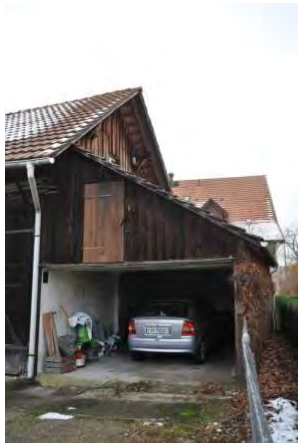
Abb. 87: Schopfanbau nach Norden mit Bretterschalung.
