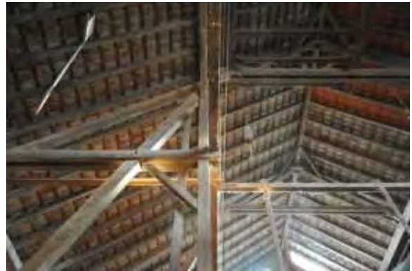
Abb. 75: Ökonomie, Blick in das Dachwerk von 1941-43.
