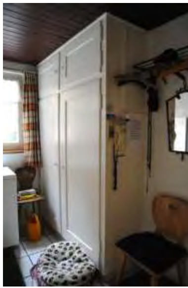
Abb. 43: Vorplatz 002, Einbauschränk, 2. Hälfte 20. Jh. Blick nach Südosten.
