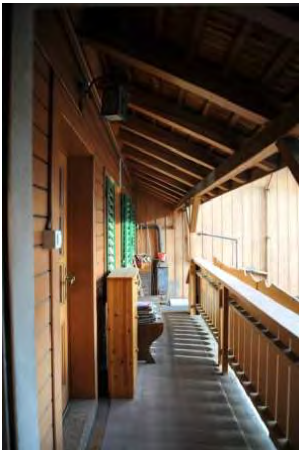
Abb. 64: Verbindungsbau mit Laube von 1941. Blick nach Osten.
