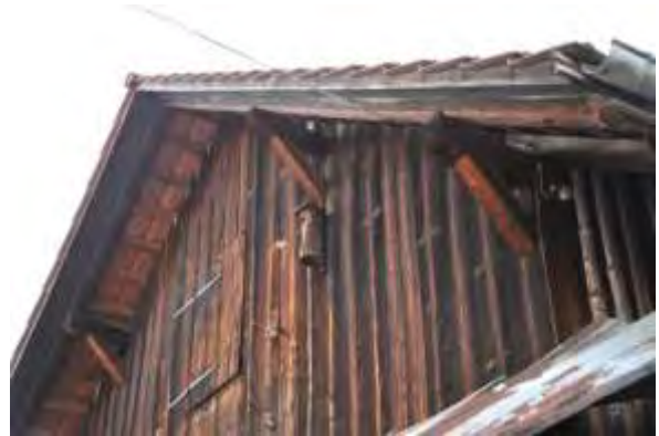
Abb. 83: Verschalte südliche Giebelfassade im Giebfeld.
