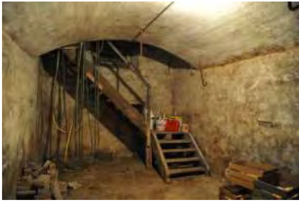
Abb. 90: Gewölbter Keller von 1882, Blick nach Südosten.
