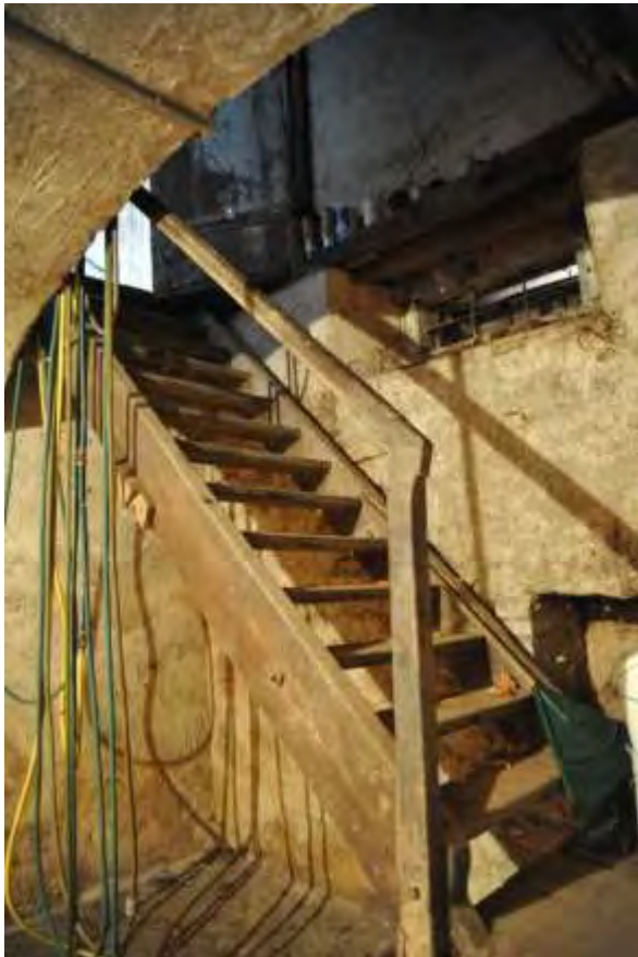
Abb. 92: Gewölbter Keller mit Treppenabgang. Blick nach Osten.
