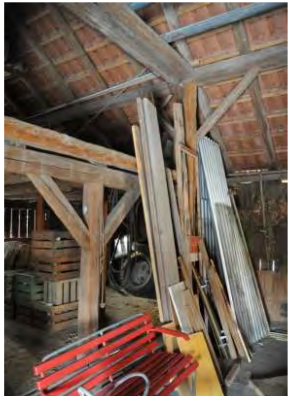
Abb. 106: Dachwerk mit Q2, Blick nach Westen.
