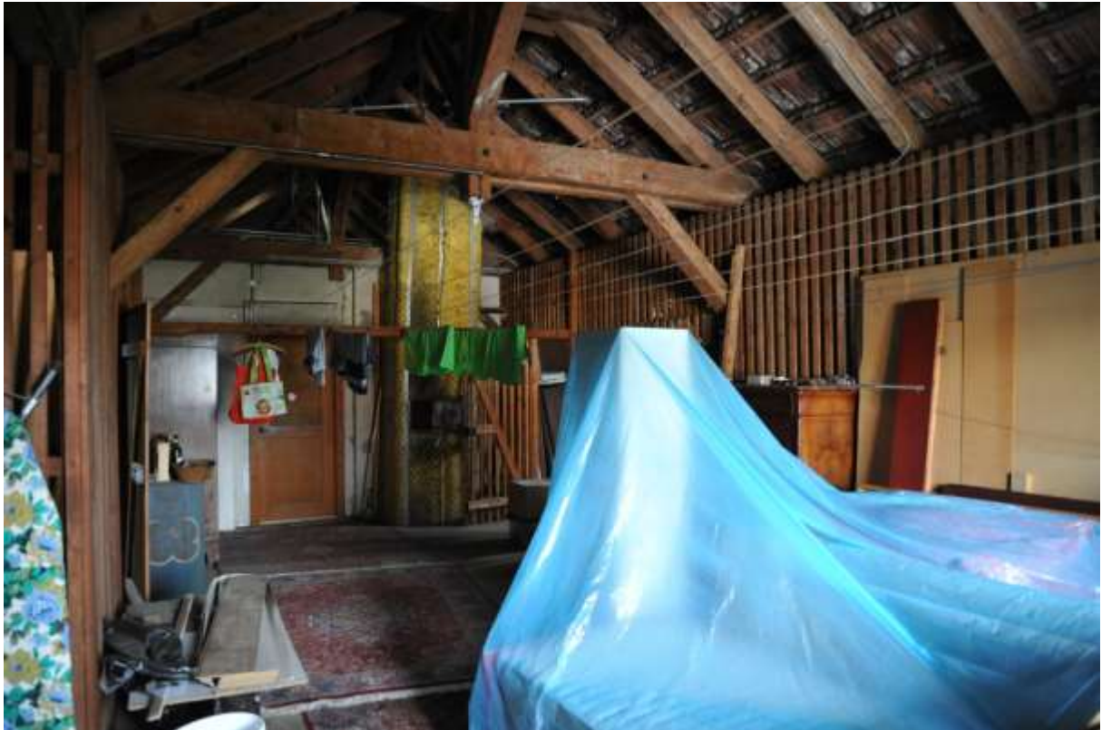
Abb. 69: Dachgeschoss, Blick nach Süden.
