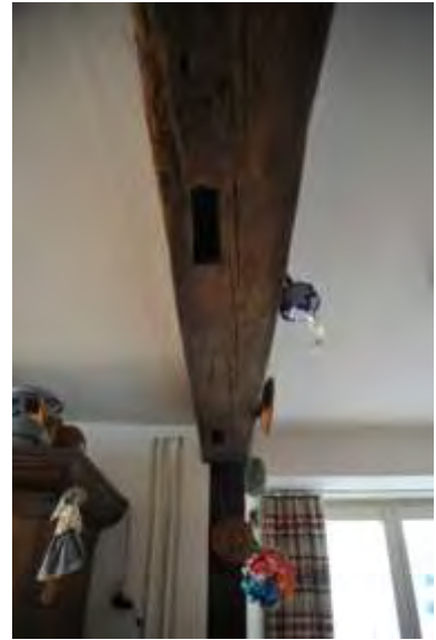
Abb. 55: Küche 005 mit Nebenstube 004, das Holzgerüst zeigt Zapflöcher des ehemaligen Fachwerks. Die Hölzer entstammen dem Vorgängerbau von 1819. Blick nach Westen.
