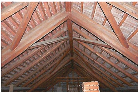
Abb. 18: Ehemalige Ökonomie, 2. Dachgeschoss, Blick Richtung Westen. Blick an die Stuhlkonstruktion mit den Querbünden Nr. 5-7.
