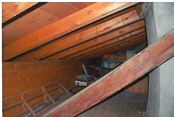
Abb. 19: Wohnhaus, 2. Dachgeschoss, südlicher Dachfussbereich mit Sicht auf die Rafen der Schleppdachlukarne (1967/69).
