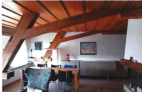
Abb. 54: 1. Dachgeschoss, Wohnhaus, Wohnzimmer. Blick Richtung Westen. Im Bild der 2. und 3. Querbund von Osten.
