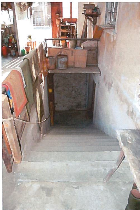
Abb. 34: Untergeschoss, Wohnhaus. Blick vom Erdgeschoss die Kellertreppe hinunter.
