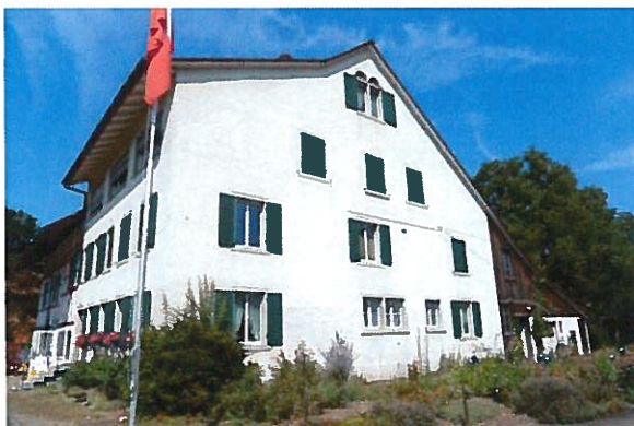
Abb. 30: Ostfassade, Wohnhaus. Blick von Süden.
