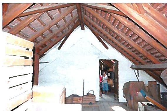
Abb. 63: 2. Dachgeschoss, ehemalige Ökonomie. Blick Richtung Osten.
