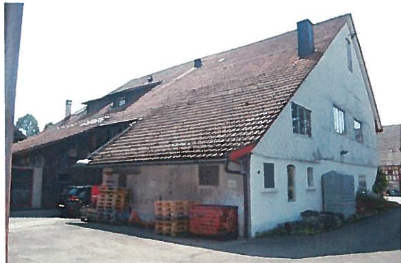
Abb. 27: Nord-/Westfassade, Übergang zur Werkstatt.
