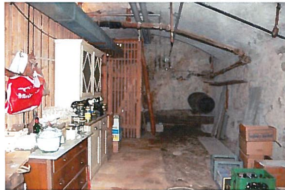
Abb. 33: Untergeschoss, Wohnhaus. Blick Richtung Osten. Raumunterteilung mittels Holzgerüst. Am Boden sind Tonziegel und Lesestein-Belag sichtbar.
