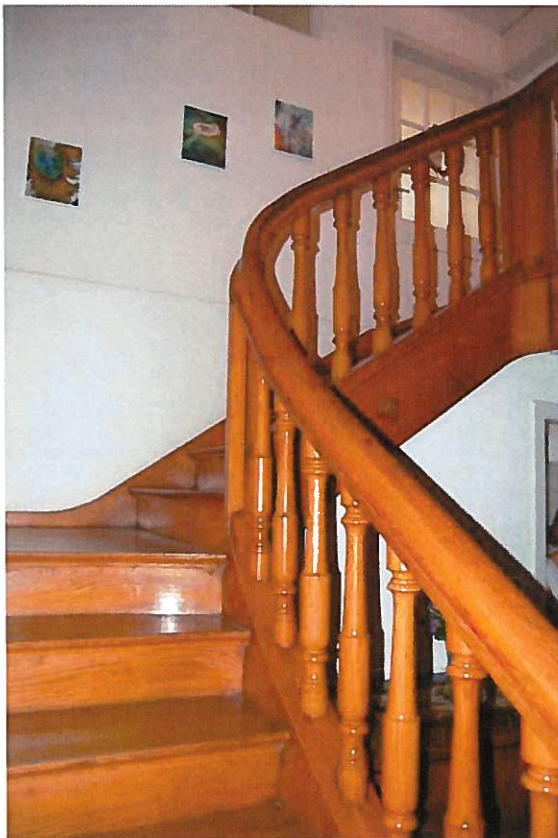
Abb. 38: Erdgeschoss, Wohnhaus, Eingangshalle. Blick in das 1. Obergeschoss.
