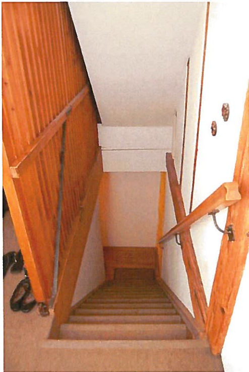
Abb. 57: 1. Dachgeschoss, Wohnhaus, Treppe zum 1. Obergeschoss.
