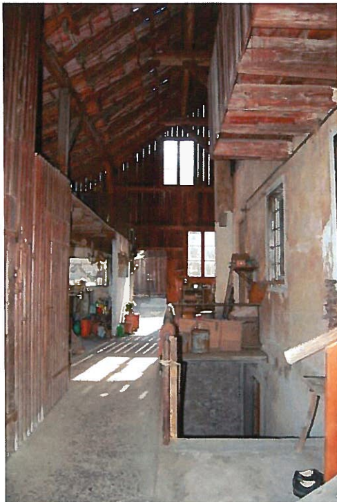
Abb. 28: Nordfassade, Wohnhaus. Im Bild die Kellertreppe und die Einbauten im Schopf fanbau.
