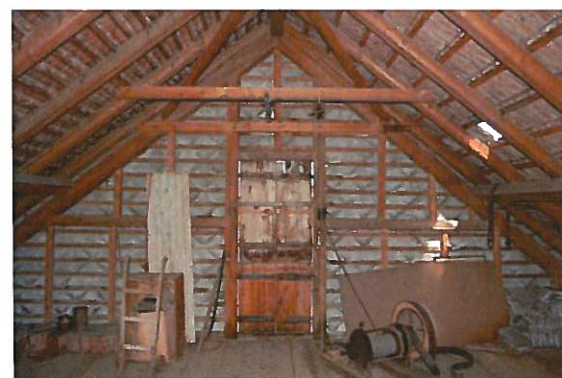
Abb. 64: 2. Dachgeschoss, ehemalige Ökonomie. Blick Richtung Westen.
