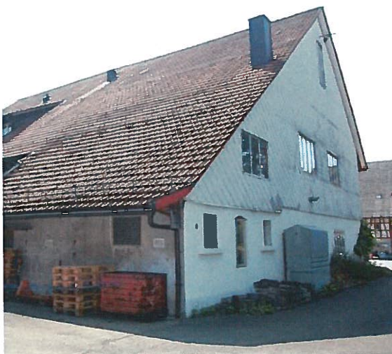
Abb. 24: Westfassade mit Blick von Norden.
