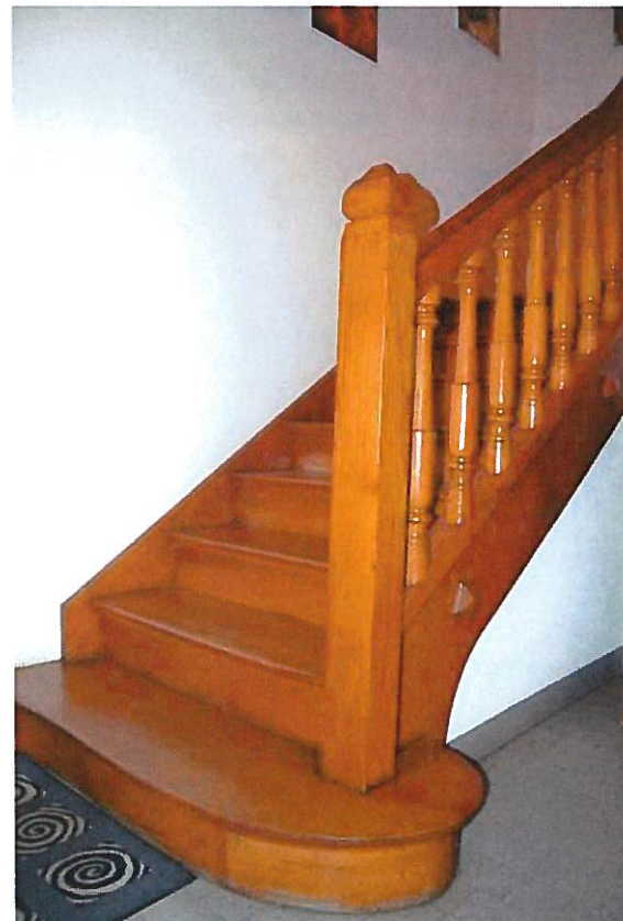
Abb. 39: Erdgeschoss, Wohnhaus, Eingangshalle. Antrittspfoften.
