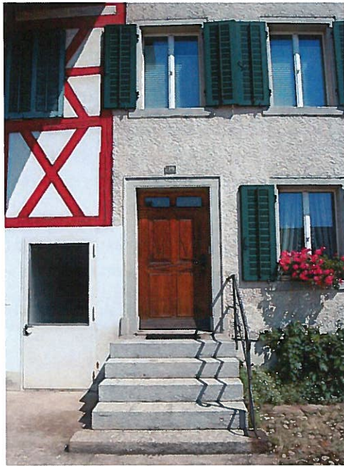
Abb. 22: Südfassade, Wohnteil. Detail des Hauseingangs.
