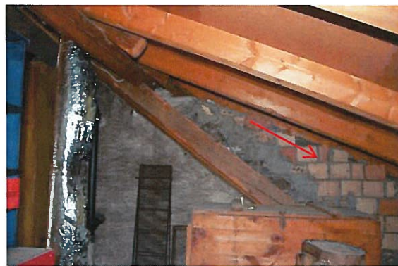
Abb. 60: 2. Dachgeschoss, Wohnhaus. Blick Richtung Osten. Roter Pfeil markiert den östlichen Spickel, welcher durch die Dachanhebung mit Backsteinen ausgefüllt wurde.
