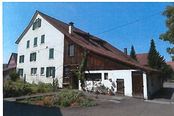
Abb. 31: Ostfassade, Wohnhaus mit Schopf fanbau gegen Norden.
