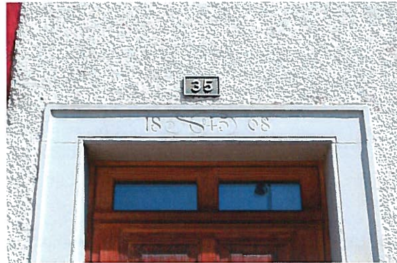
Abb. 23: Südfassade, Wohnteil. Inschrift im Türsturz des Hauseingangs.
