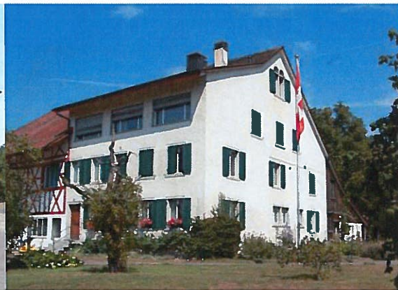
Abb. 21: Süd- und Ostfassade des Wohnhauses. Gegen Norden schliesst sich der holzverschalte Schopfanbau an
