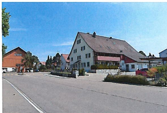
Abb. 12: Blick von der Petergasse zur Dorfstrasse 35.
