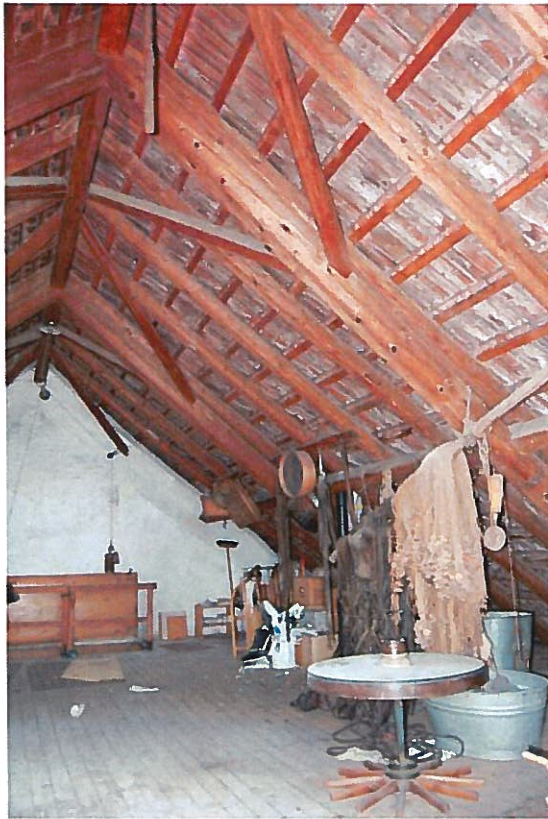
Abb. 16: Wohnhaus, 2. Dachgeschoss, Blick Richtung Westen.
