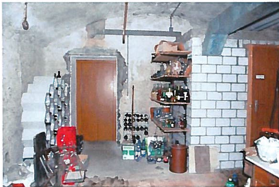
Abb. 32: Untergeschoss, Wohnhaus. Blick Richtung Westen an die modernen Einbauten mit Lift und Technikraum.
