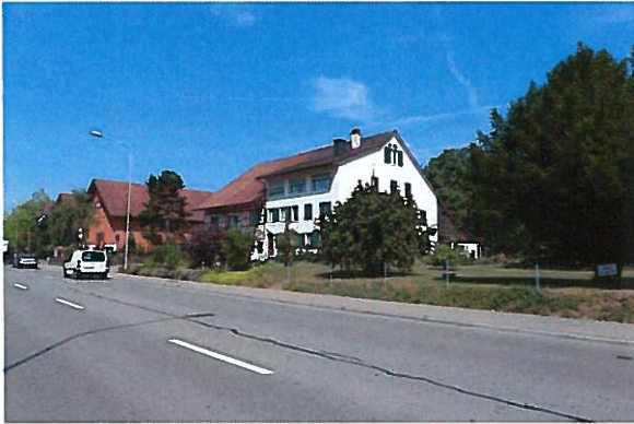
Abb. 15: Dorfstrasse 35 mit Vorgartenzone, östlicher Freifläche und Baumbestand.
