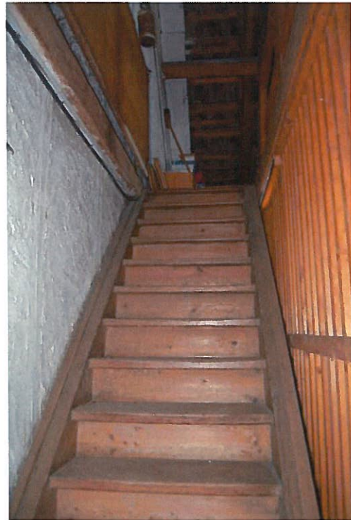
Abb. 58: 1. Dachgeschoss, Wohnhaus, Treppe zum 2. Dachgeschoss.
