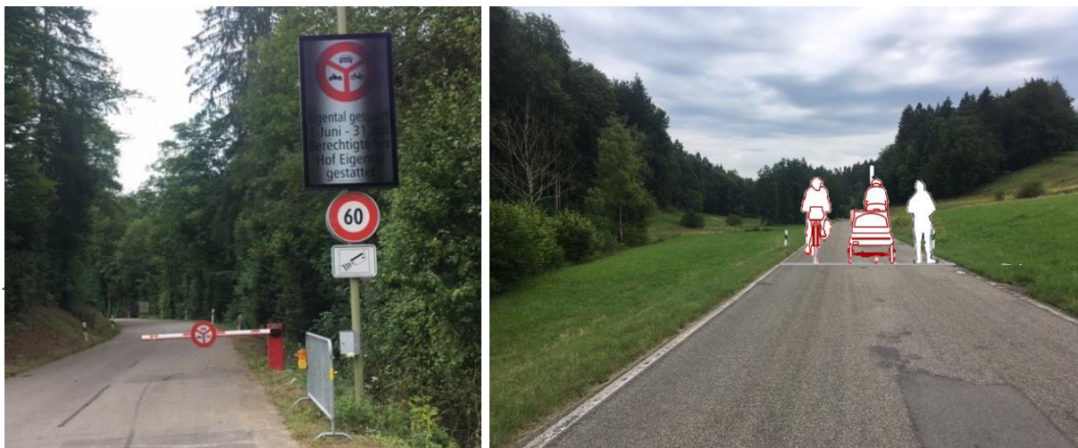
Abb. 6: Catch-Ken Videoüberwachungssystem mit automatischer Schranke Eingang von Oberembrach.
